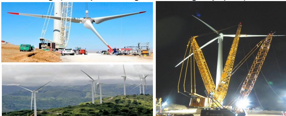
Gambar II.9 Pengerjaan Proyek Pembangkit Listrik Tenaga Bayu (PLTB)
