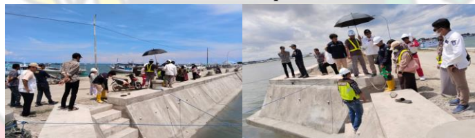
Pekerjaan Rehabilitasi Turap Penahan Tanah (Ravetment) Di PPI Lonrae Kabupaten Bone
