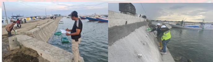
Pengawasan Rehabilitasi Turap Penahan Tanah (Ravetment) Di PPI Lonrae Kabupaten Bone
