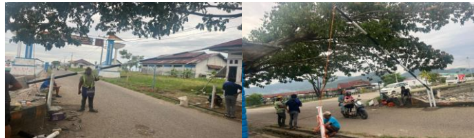
Pembangunan Portal Jalan besi Pelabuhan Perikanan Wilayah I Lokasi PPI Pontap Kota Palopo
